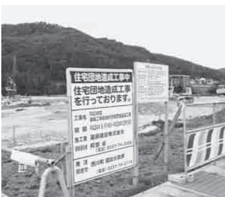
▲ 住宅団地造成地
