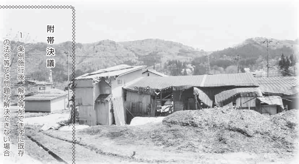
▲ 水沢の国道112号線沿いにある危険な空き家
