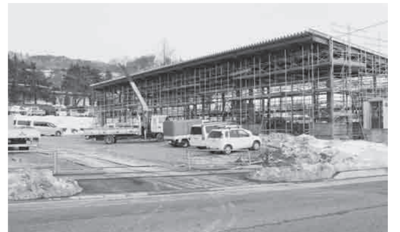
▲海味に新工場建設中のケーシー・スチール(株)
