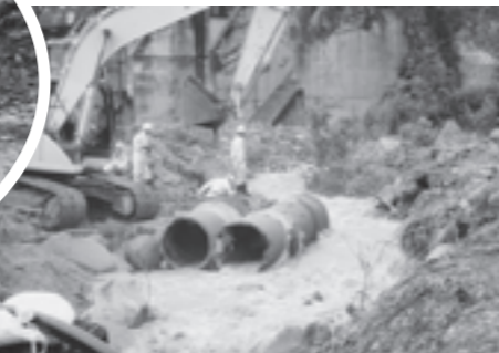
▲ 大井沢佐土橋の仮設工事
