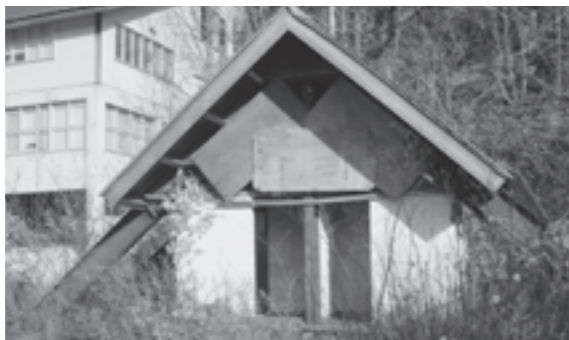
▶解体された志津地区の公衆便所
