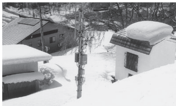
▲海味地内の大井沢受信点アンテナ柱
