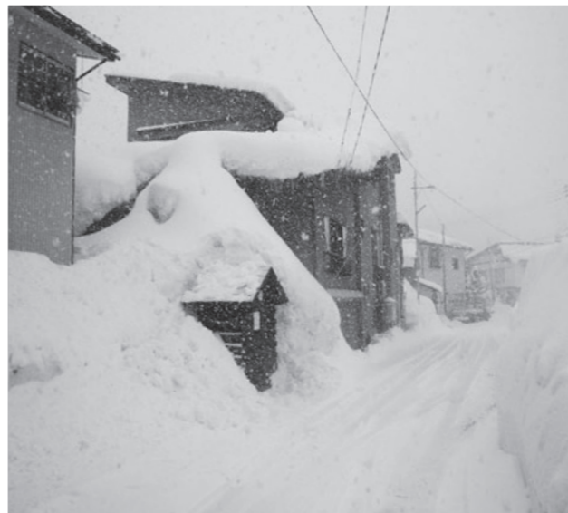
▲流雪溝が望まれる下堀裏線
