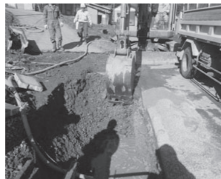
▲大井沢地区の水道管入替え工事
