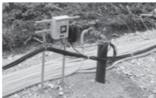
▲地下水汲み上げ機械
