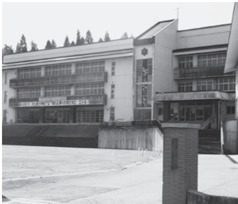
▲ 町歴史民俗資料館(仮称)として整備予定の旧川土居小学校
