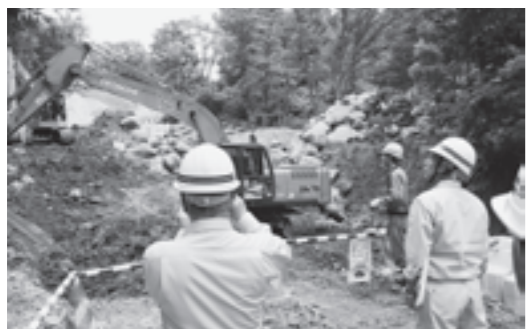
▲重機の無線操作
