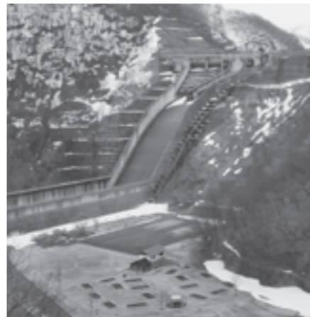
寒河江ダムの放水路
