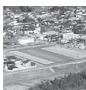
▶2期工事予定地（平成28年10月撮影）
