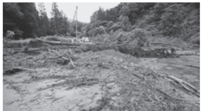
大井沢の上島地区内の町道被災現場
