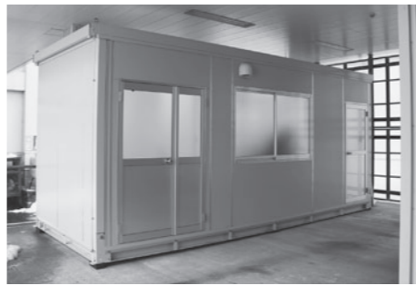
▲町立病院の救急車ピットに設置された陰圧ハウス ※陰圧とは内部の気圧を下げ外部に空気が漏れないようにすること。
