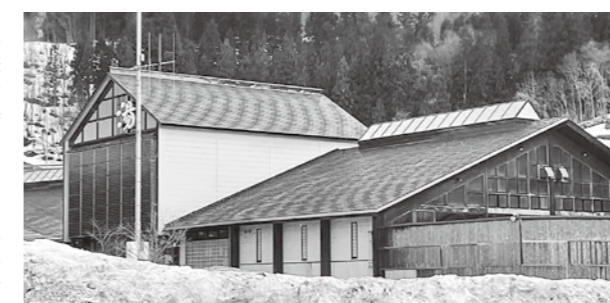
▶改修が待たれる水沢温泉館
