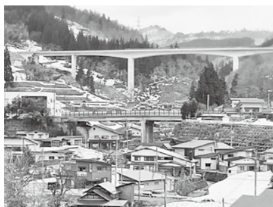
▶平行して走る山形自動車道路と国道112号
