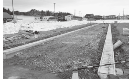
▲みどり団地第二期工事
