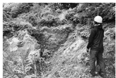
▲岩根沢参道災害現場
