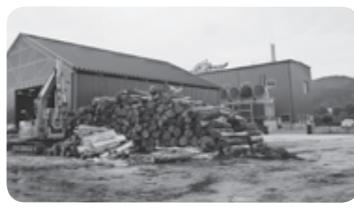
▶鶴岡市のバイオマス発電所
