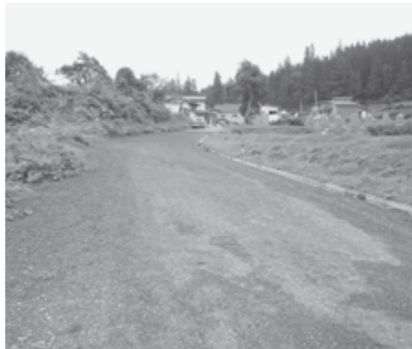
▲本舗装されていない町道立目南野線
