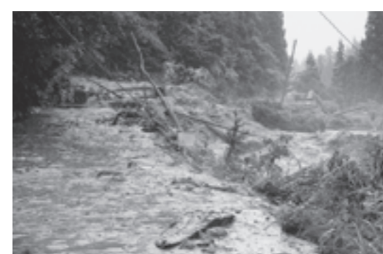
▶平成25年豪雨災害 間沢川地内の土石流
