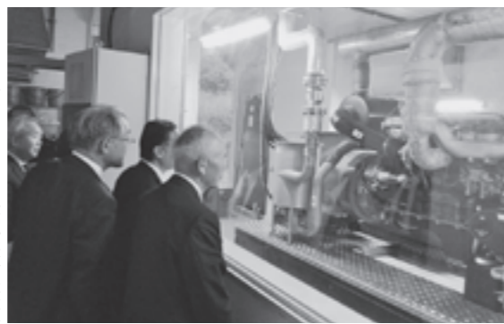
▶バイオマス熱電供給装置
