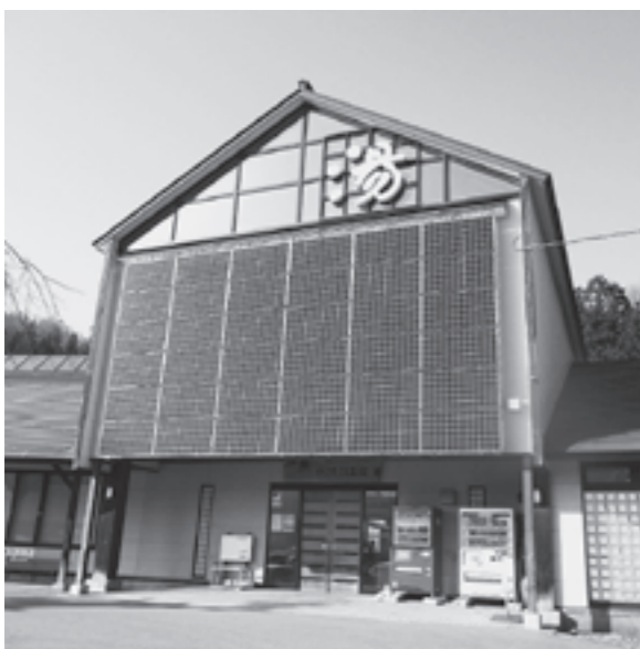
▲水沢温泉館に設置されている太陽光パネル
