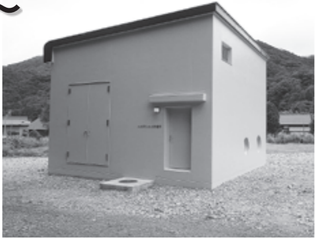
▶大井沢小水力発電所の外観
