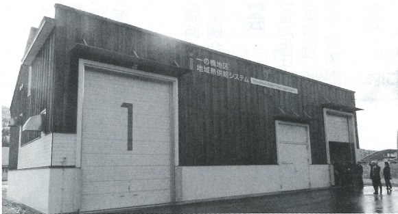
▲一の橋地区地域熱供給システム
