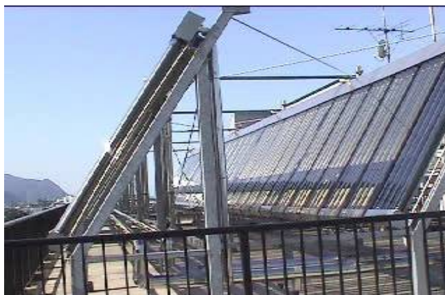
写真 7-9 新潟県糸魚川市の老人福祉施設の屋上に設置された太陽熱集熱装置
