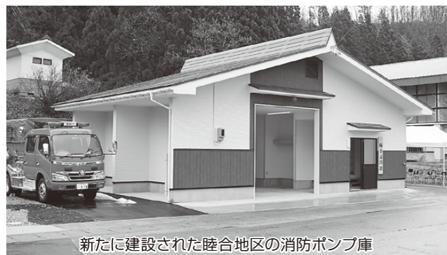
新たに建設された睦合地区の消防ポンプ庫
