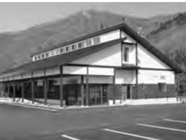
大井沢温泉「湯ったり館」 地域材の西山杉を贅沢に使った室内空間で、「月山の湯」と「朝日の湯」の2つの風呂がある。
