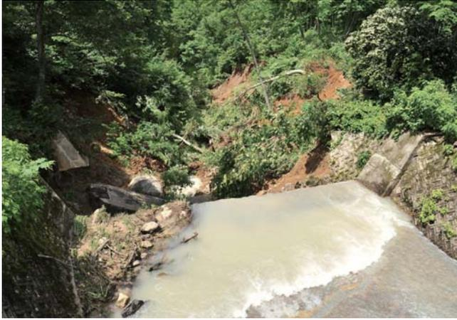
河川洗掘によって兩岸の崩落が進む志津地区の中沼川
