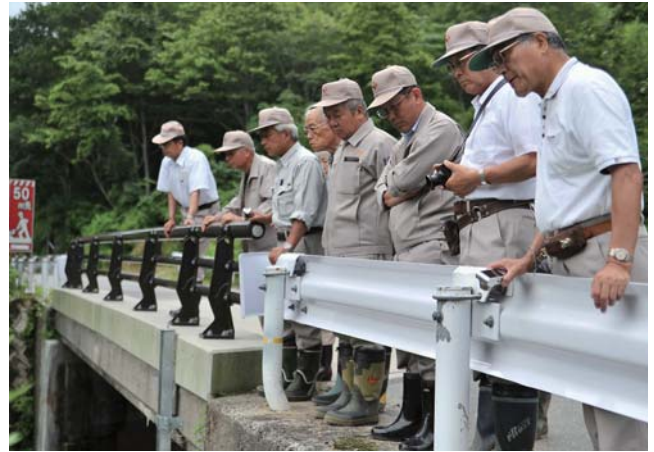
志津「中沼沢川橋」では日々崩れ落ちている岸の状況を確認
