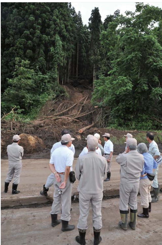
「県道 寒河江西川線」の大規模な土砂災害を目の当たりにする
