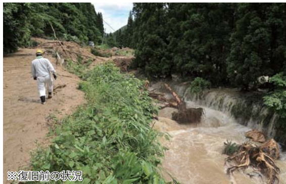
※復旧前の状況
