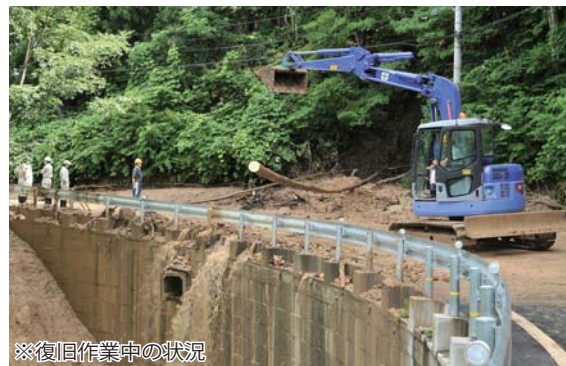
※復旧作業中の状況
